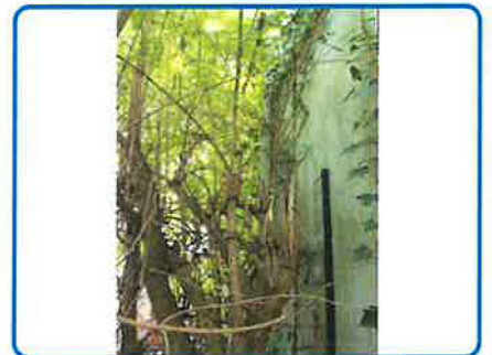
Sondage sur ZPSO n° 4 : Descentes 4 EP Fibres ciment (dans Immeuble principal Enveloppe Clos)
