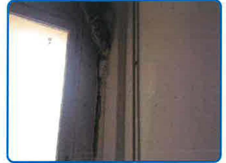
Décision opérateur n° 8 : Conduits vertical Fibres ciment Peinture (dans Immeuble principal RDC Appt duplex Buanderie)
