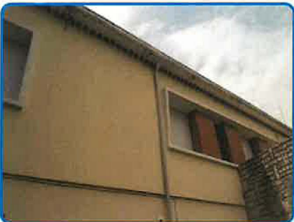
Sondage sur ZPSO n° 4 : Descentes 5EP Fibres ciment (dans Immeuble principal Enveloppe Clos)
