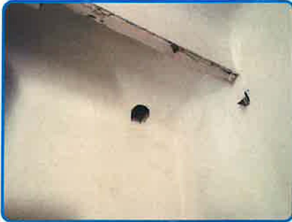
Décision opérateur n° 6 : Conduits Fibres ciment (dans Immeuble principal 1er étage Appt duplex Cuisine)
